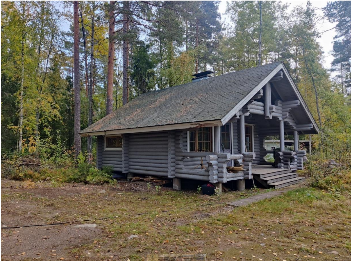
Kuva 3. Purettava ja korvattava rakennus
