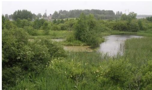
Kuva 1. Hulevesikosteikko koostuu useista vesiensuojelun kannalta tärkeistä osista: syvistä altaista, matalasta ilmaversoisten kasvien vyöhykkeistä, tulvaniitystä ja suojapuustosta sekä pensaistosta. Suunnittelun yksityiskohtiin vaikuttaa puhdistettavan veden laatu ja määrä sekä käytettävissä oleva tila.
