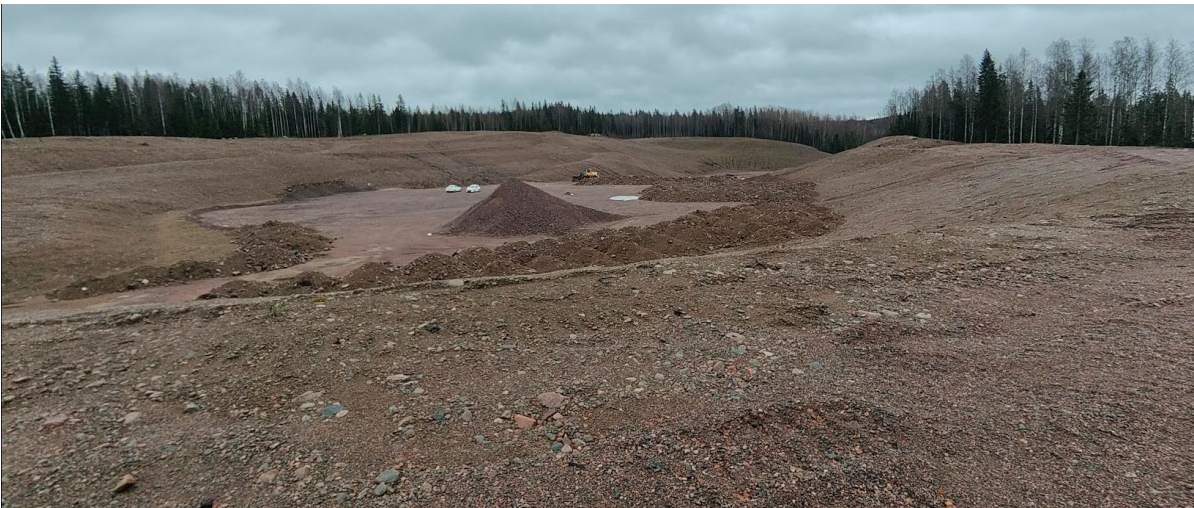
Kuva 2. Alue kuvattuna 13.11.2024 reuna-alueiden muotoilun ja pintamaiden levitysten jälkeen. Pintamaakasat valmiina levitystä varten ottotasolla.
