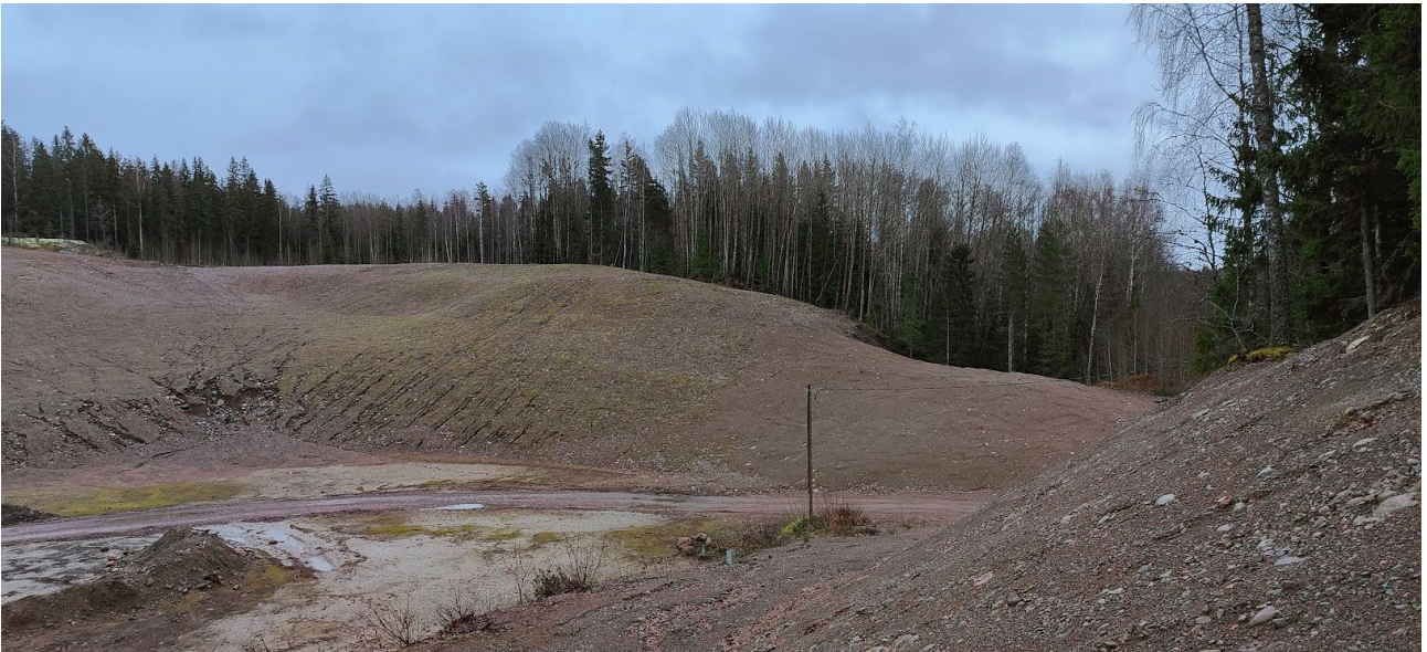
Kuva 3. Alueelta 13.11.2024 alueen itäpuoli. Reuna-alue valmiina istutuksia varten.
