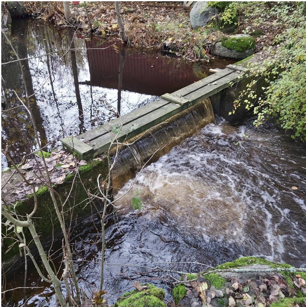
Kuva 4. Nykyinen pato, ylävedenkorkeus N43+104,78 m ja alavesi noin 30 cm alempana
