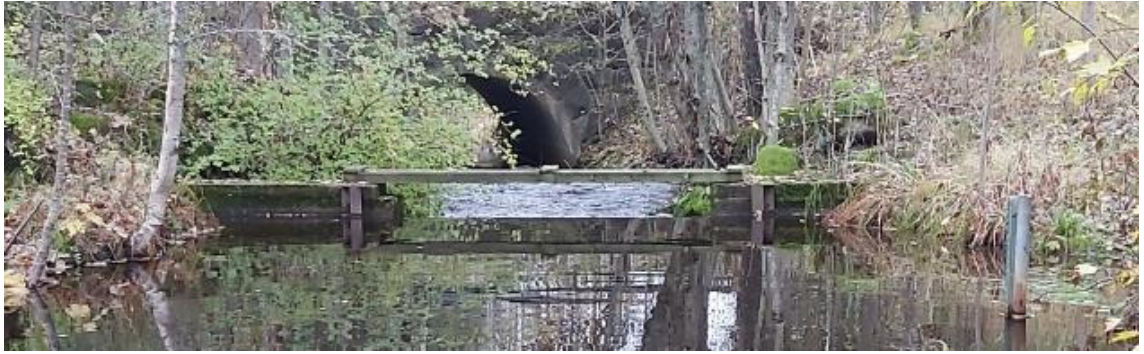
Kuva 2. Nykyinen pato ylävirran suunnasta
