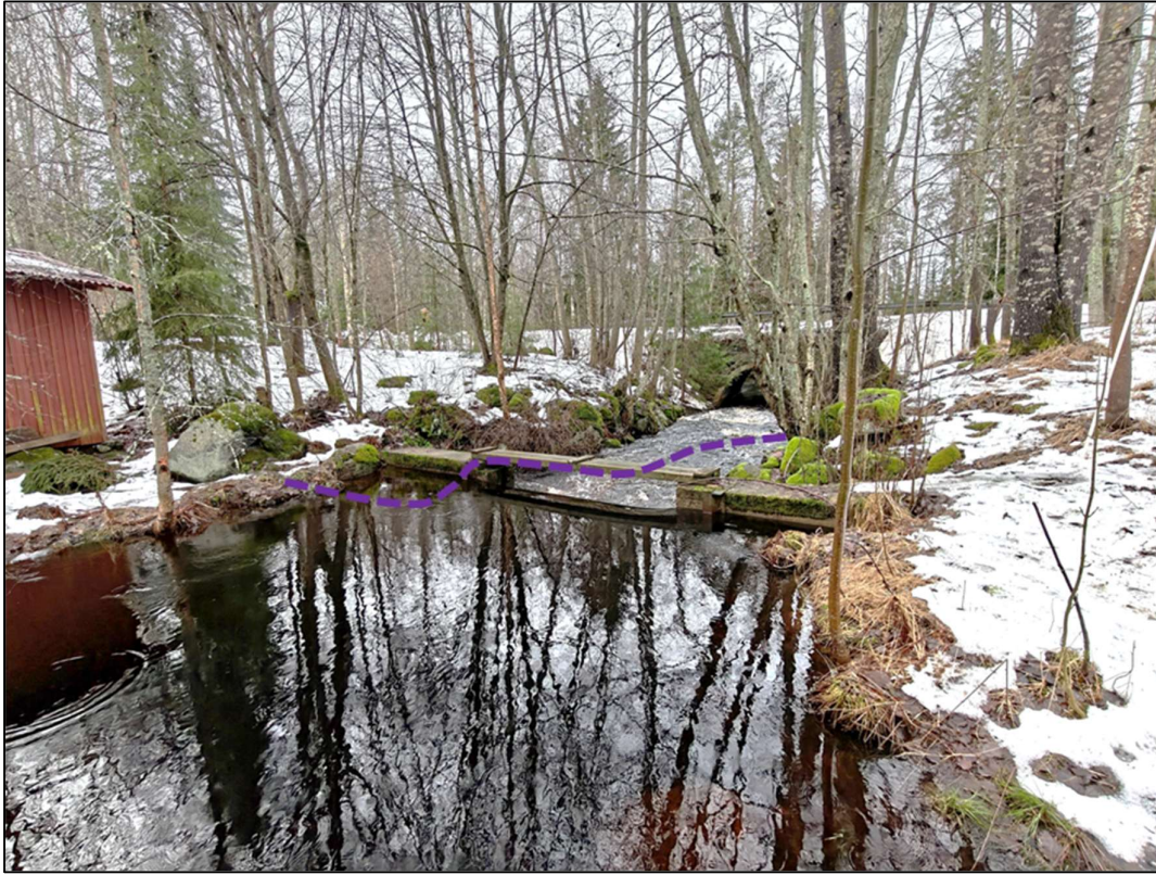
Kuva 6. Nykyinen pohjapato ja hahmotelma tulevan pohjapadon linjauksesta.
