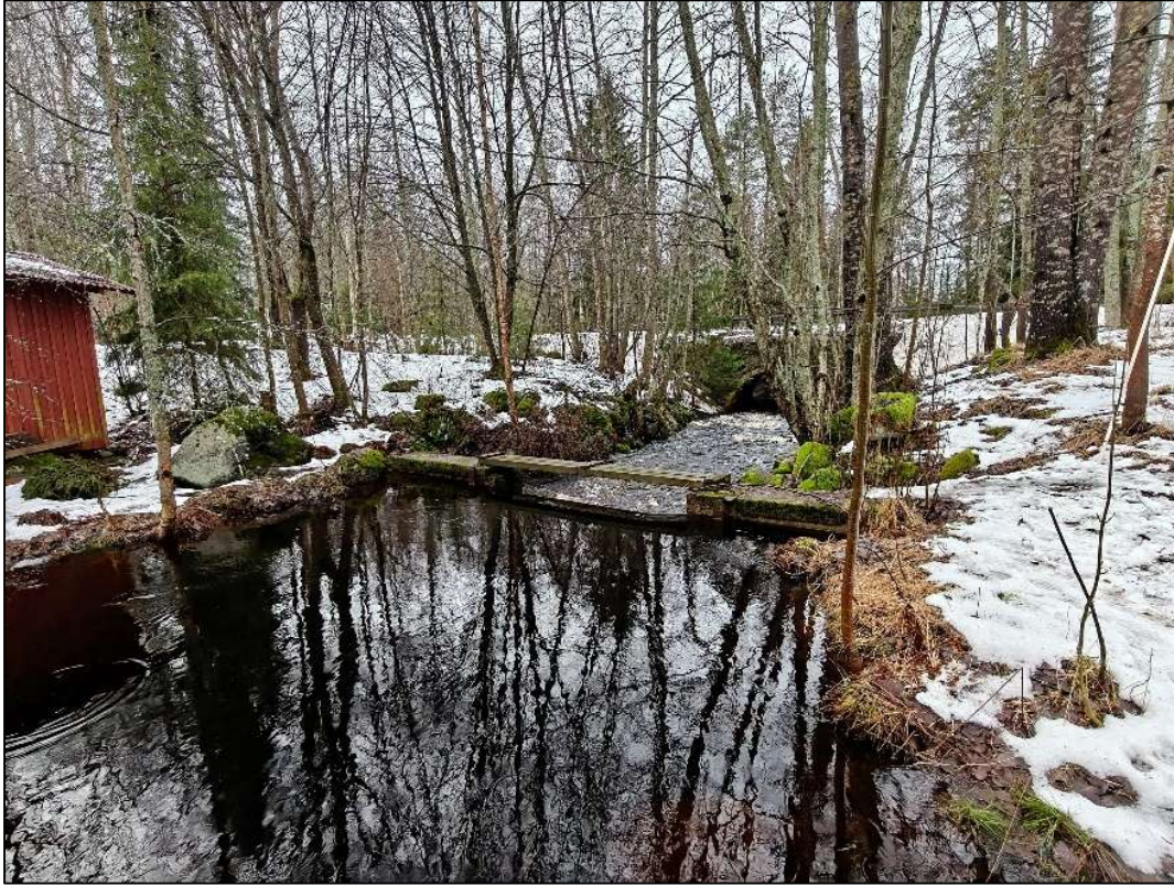
Kuva 3. Nykyinen patorakenne Vaskijärven luusuassa (Kuva: J-P Saarelainen 30.1.2025).
