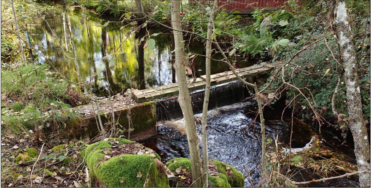
Kuva 6. Nykyinen säännöstelypato Vaskijärven luusuassa (FCG 5.9.2025).
