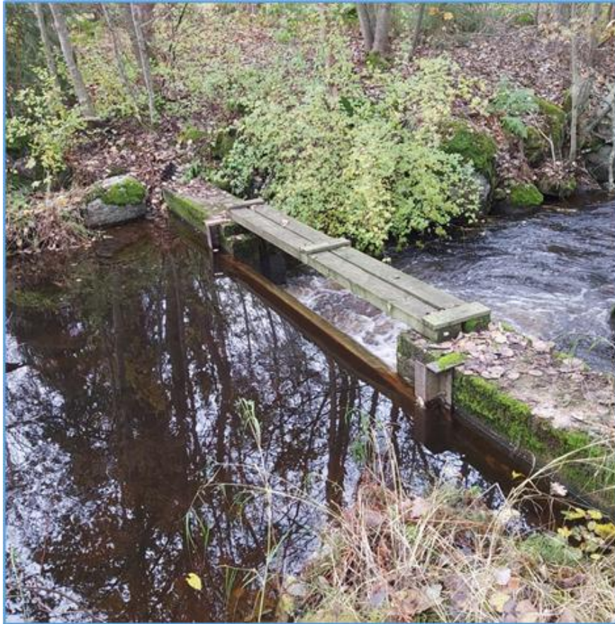
Kuva 2. Vaskijärven yksiaukkoinen settilankkupato. Maveplan Oy 24.10.2023.
